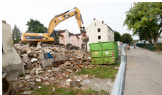
Abbrucharbeiten im Zeppelinweg.
