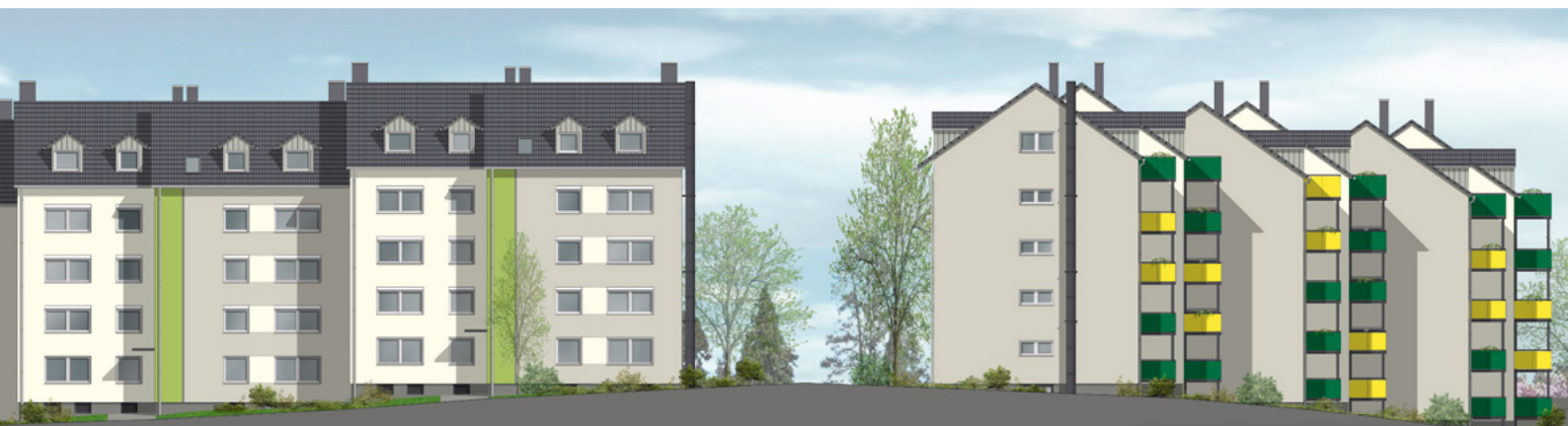
Westansicht am Heddesdorfer Berg.
