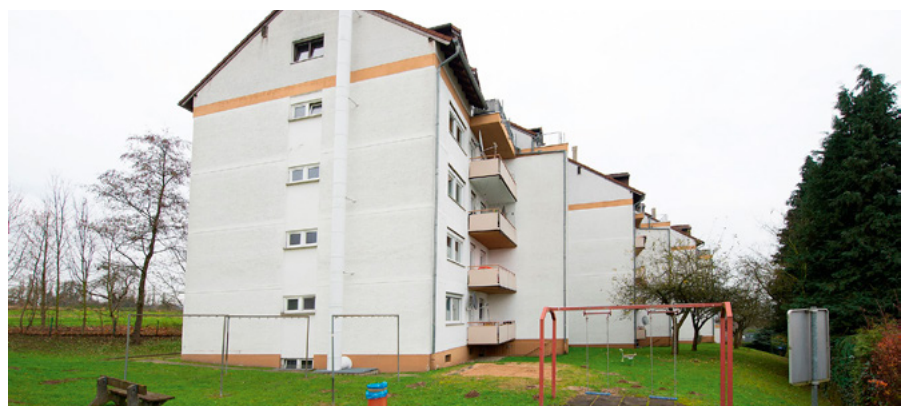
GSG-Wohnanlage vor der Sanierung.
