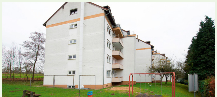
GSG-Wohnanlage vor der Sanierung.
