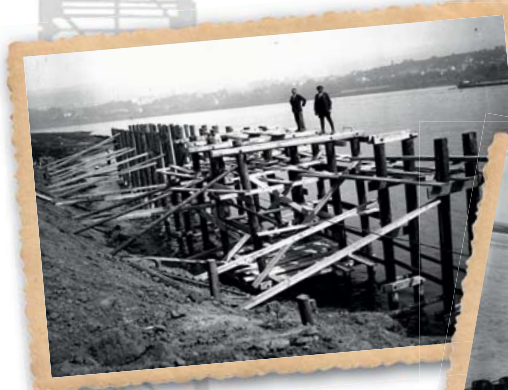
Bau der Deichmauer aus Stahlbeton auf Rammpfählen
