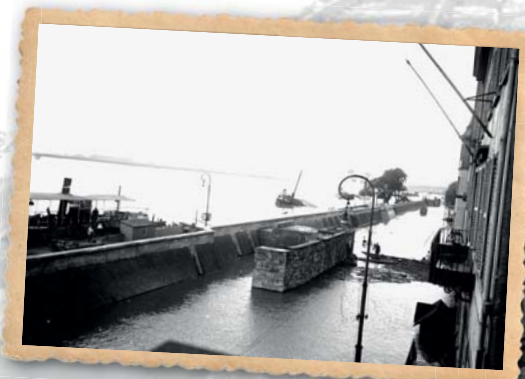
Hochwasser während des Deichbaus
