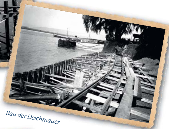
Bau der Deichmauer aus Stahlbeton auf Rammpfählen
