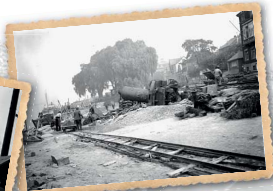
Riesige Mengen Tonerde, Lehm, Kies, Steine, Beton, Zement und Eisen karrte man zur Baustelle.
