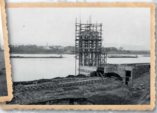
Bau des Pegelturms – Wahrzeichen der Stadt Neuwied
